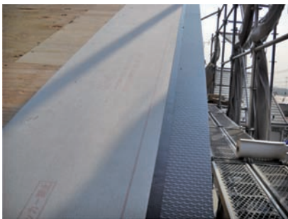
②軒先・ケラバに通気部材を留め付けます。
