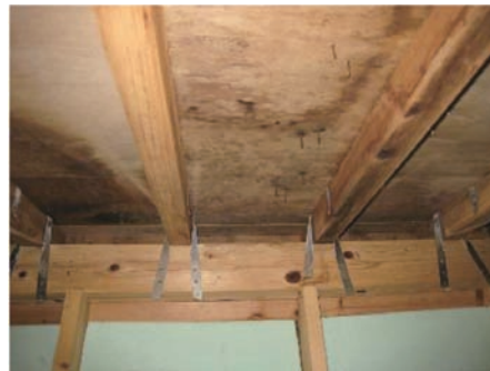
図9 野地板 屋根断熱の断熱材を剥がしたところ。結露水により野地板が濡れている。
