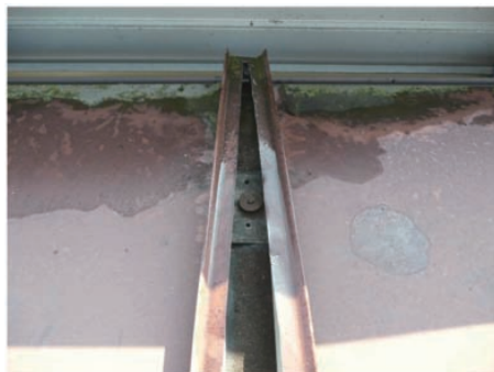
図11 金属屋根(軒先部) パラペットの日陰部分は霜が乾かない。キャップの中側も濡れている。
