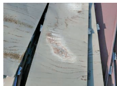
図12 金属屋根の裏面腐食
