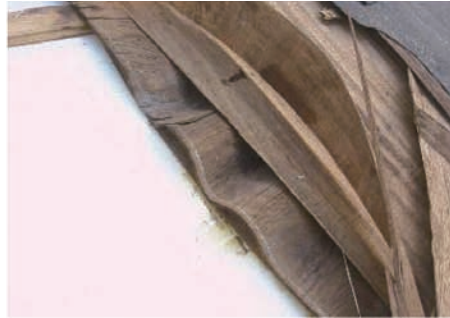
図6 断熱材通気層 結露により合板が層状剥離をしている。
