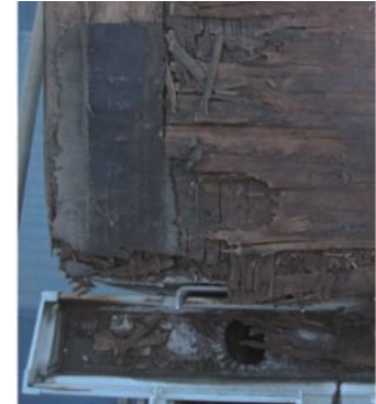
図10 化粧スレート(軒先・ケラバ部) 合板が腐朽によりボロボロとなっている。
