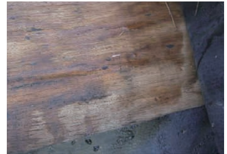
図7 野地上での結露水 ルーフィングをはがしたところ野地上でも結露していた。
