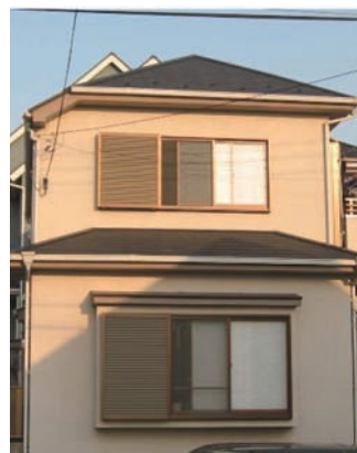
図2 外観 影から北面に日が当たっていないのわかる。
