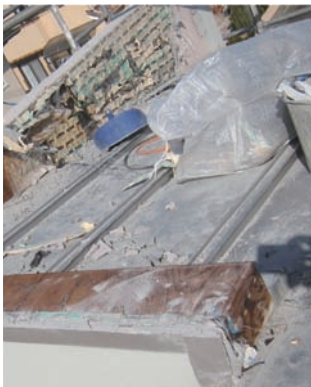
図8 金属屋根(パラペット) パラペット部の合板も腐朽していた。
