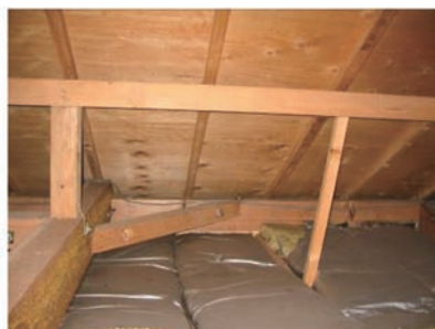
図4 南面野地板 腐朽・劣化なし。
