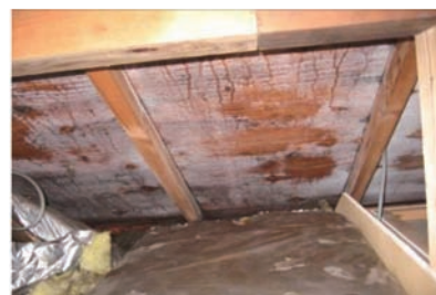
図3 北面野地板(軒先) 結露により野地板に発生したカビが白くなっている。
