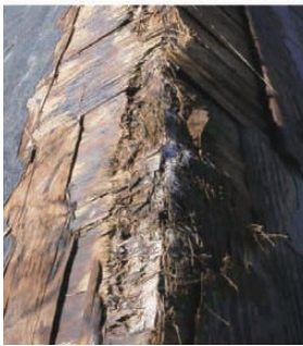
図5 野地板(棟部) 結露により合板が腐朽している。
